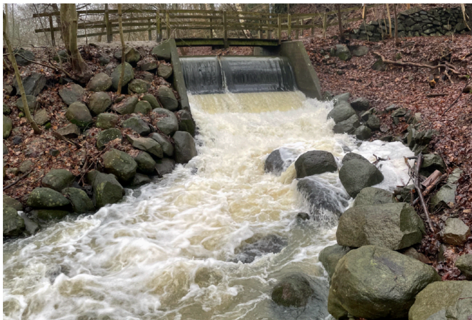
Fig 2. Nuvarande situation, ca 2,5m överfallsutlopp ur dammen
