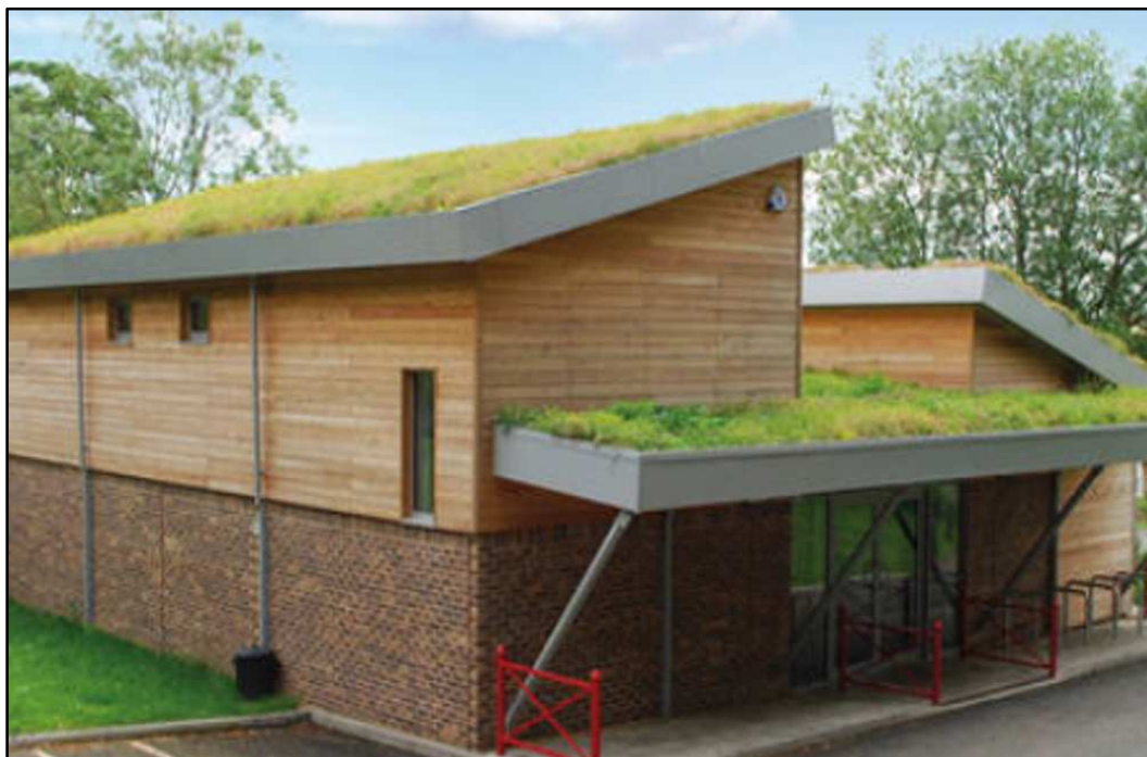
Figur 19. Sedumtak kan anläggas både på platta och lutande tak (Svenska Naturtak AB, 2018).
