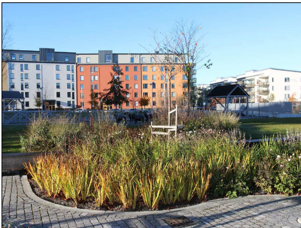
Figur 17. Exempel på nedsänkt växtbädd (Solna stad dagvattenstrategi, 2018).
