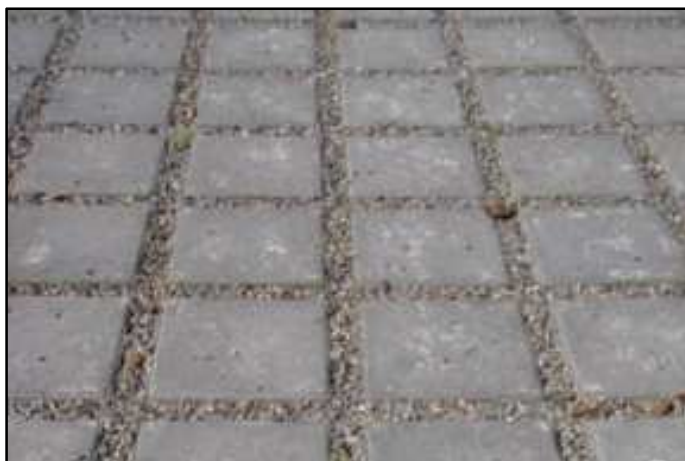
Figur 10. Exempel på genomsläpplig betongbeläggning med grusfogar.
